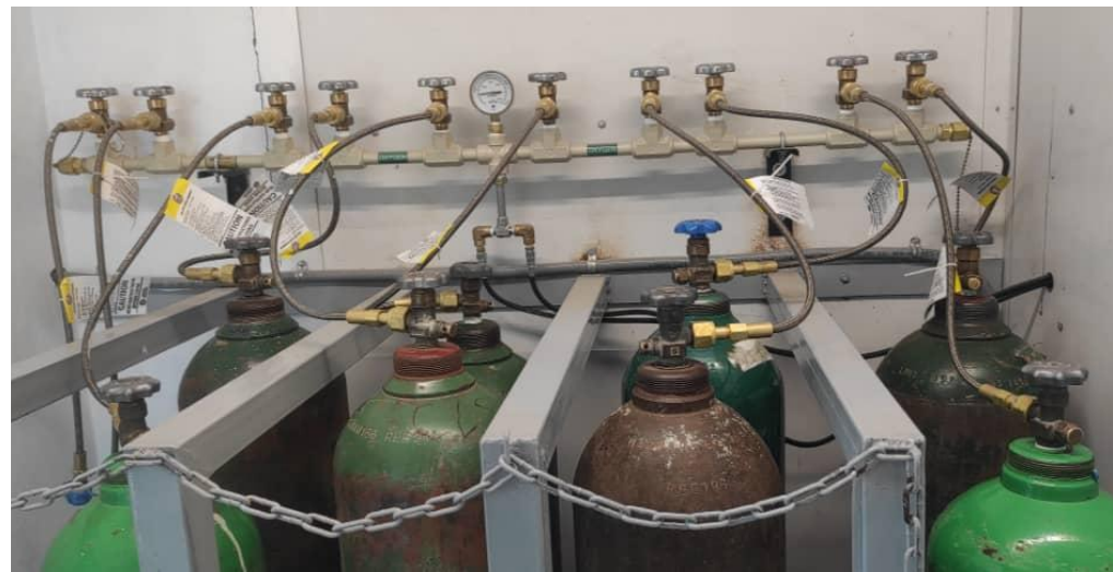
Figure 4 b : Exemple de supports à cylindres, la méthode la plus sûre de stockage des cylindres
