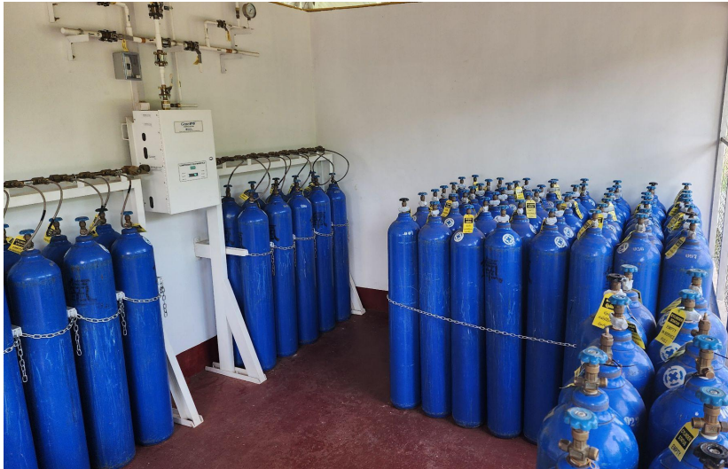
Figure 2a : Collecteur d'alimentation et de stockage des cylindres retenus par des chaînes
