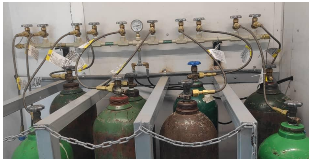
Figura 4b: Exemplo de suportes para cilindros, o método mais seguro de armazenamento
