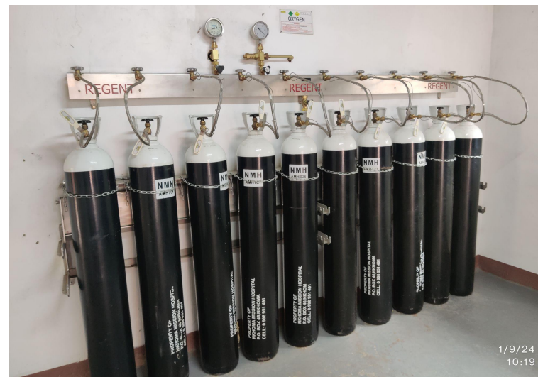
Figura 2b: Distribuidor de cilindros fixado com correntes
