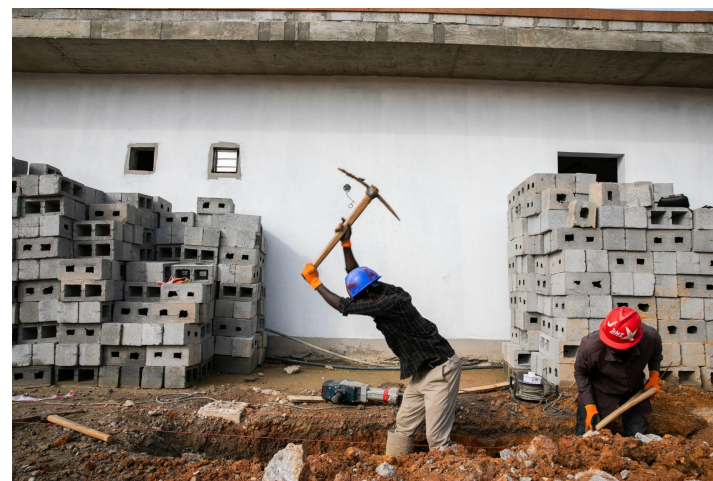
Figura 5b: Abertura de vala para MGPS subterrâneo
