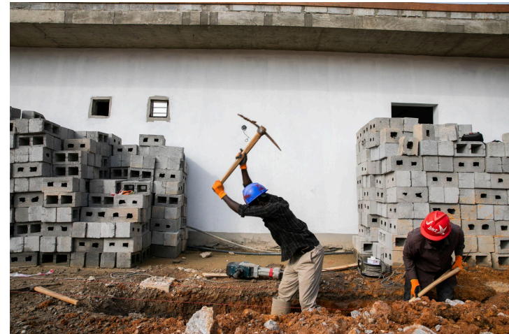
Figure 5 b : Creusage de tranchées pour le SDGM souterrain
