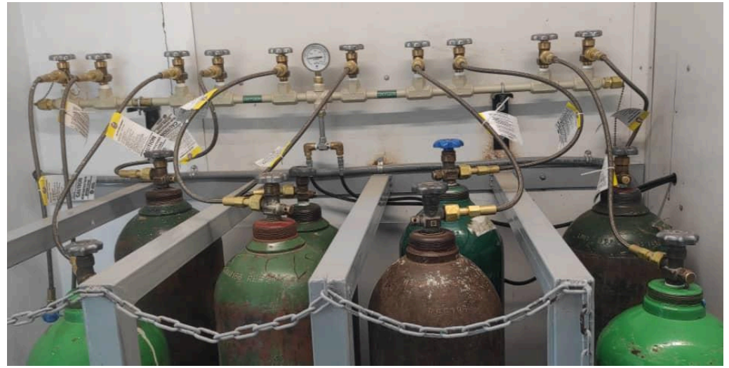
Figure 4 b : Exemple de supports à cylindres, la méthode la plus sûre de stockage des cylindres
