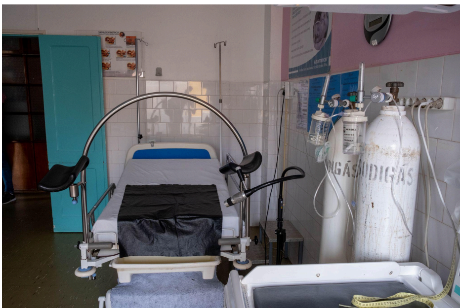
Figure 1a : Cylindres individuels au chevet du patient (retenus pour des raisons de sécurité)
