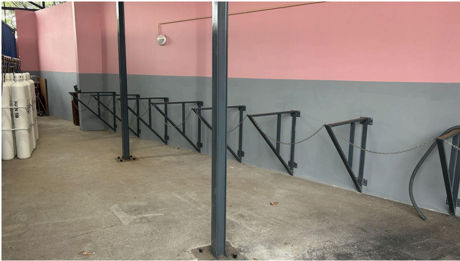
Figura 4a: Área de armazenamento de cilindros com suportes e correntes (sem cilindros na imagem)
