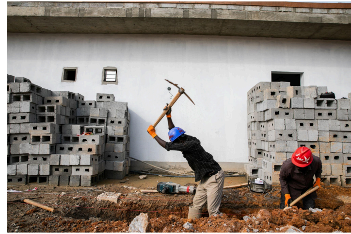
Figura 5b: Abertura de vala para MGPS subterrâneo
