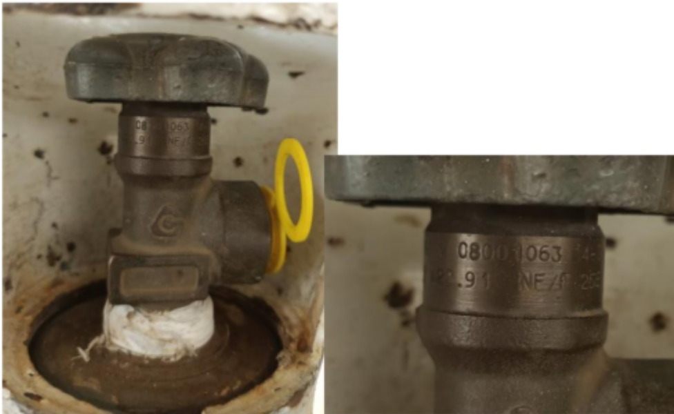
Figures 11 à 15 : Exemples de vannes de normes françaises avec les inscriptions d'identification
