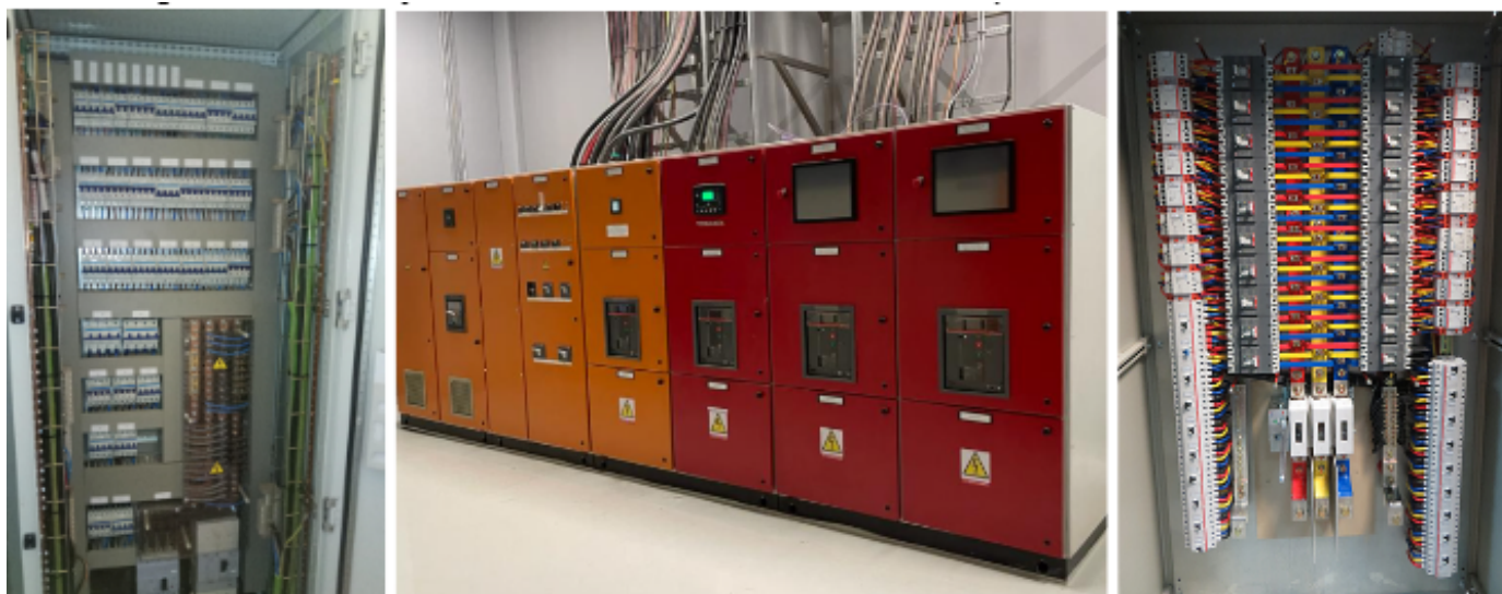
Figura 6: Exemplos de caixas bem construídas identificadas pela BHI
